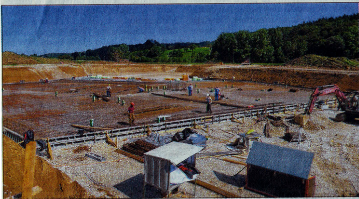
Derzeit wird die Bodenplatte betoniert.
